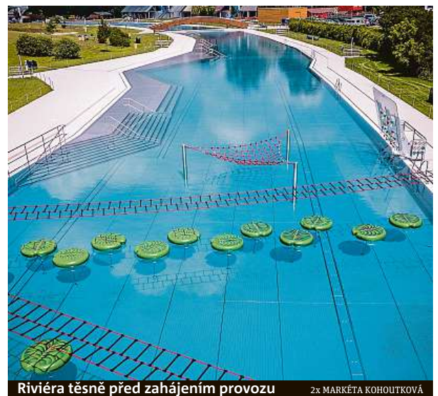
Riviéra těsně před zahájením provozu
